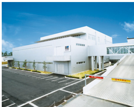
第二工場外観
