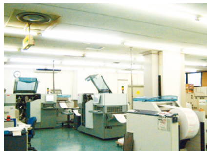
■DPS(データプリントサービス)室 2月に高速プリンター2台を増設し、ラインの能力を6割強アップしました。室内への立ち入りはACカードキーにより厳格に制限しています。
