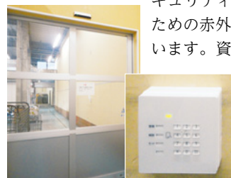
産廃置場の自動ドアと解除センサー
