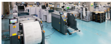
「Fusion X」3台を設置したメールサービス室
