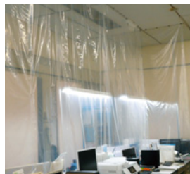
ビニールシートで入室制限
