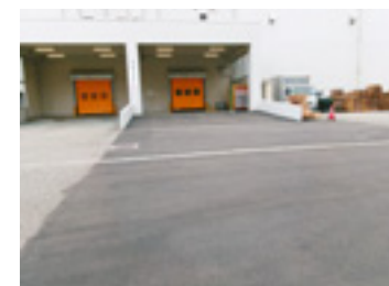
▲発送場のアスファルト舗装で路面の凹凸解消
